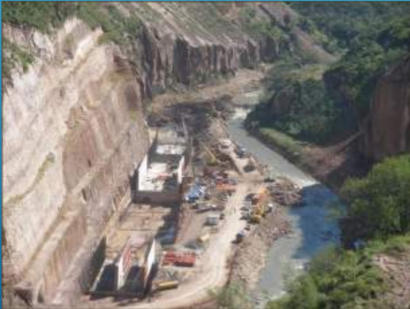
ETAPA 1 – CONSTRUCCIÓN DEL CANAL DE DESVÍO
